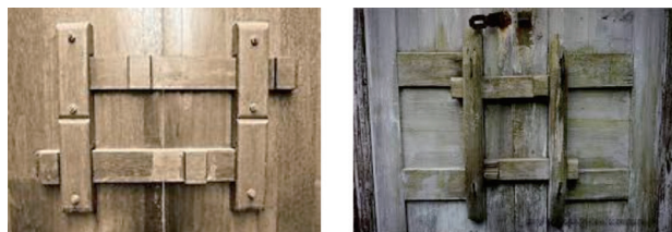
現時亦使用的木鎖和木鎖的結構圖片 (圖片來源：每日頭條)
